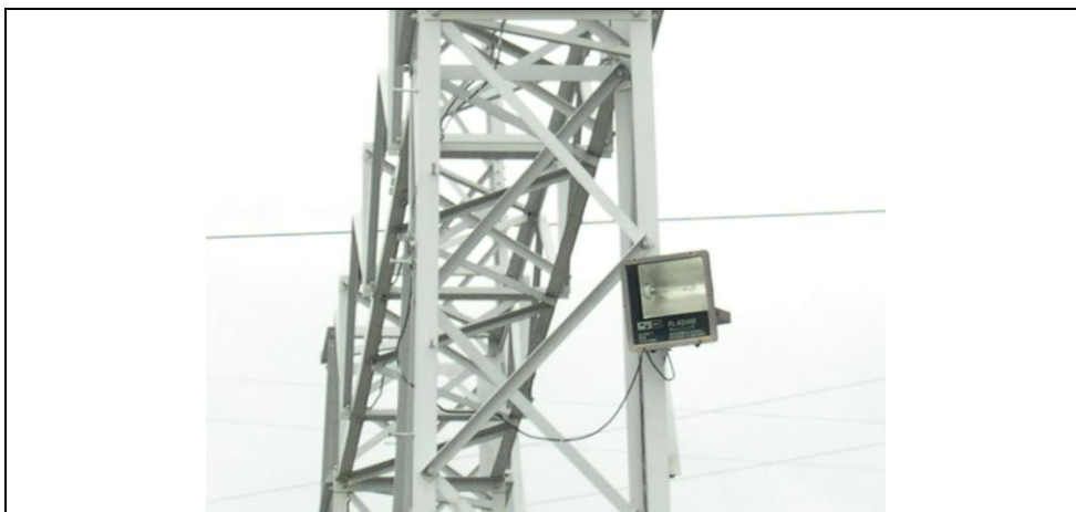
Hình 6-15. Hệ thống đèn chiếu sáng
